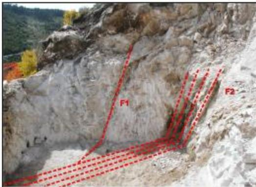
Figura 3 - Pilar P1. Traço das descontinuidades F1 e F2 nas superfícies de escavação
